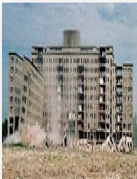
Demolición Albergue Warnes Foto: archivoteaydeportea.blogspot.com.ar
