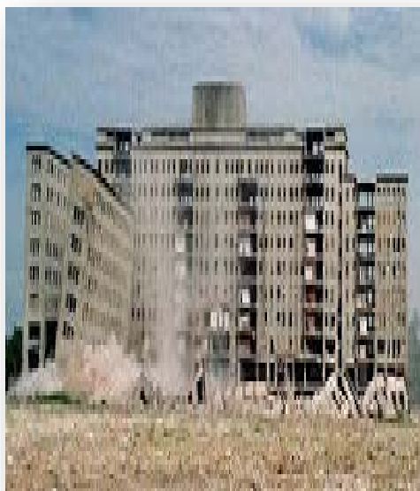
Demolición Albergue Warnes Foto: archivoteaydeportea.blogspot.com.ar
