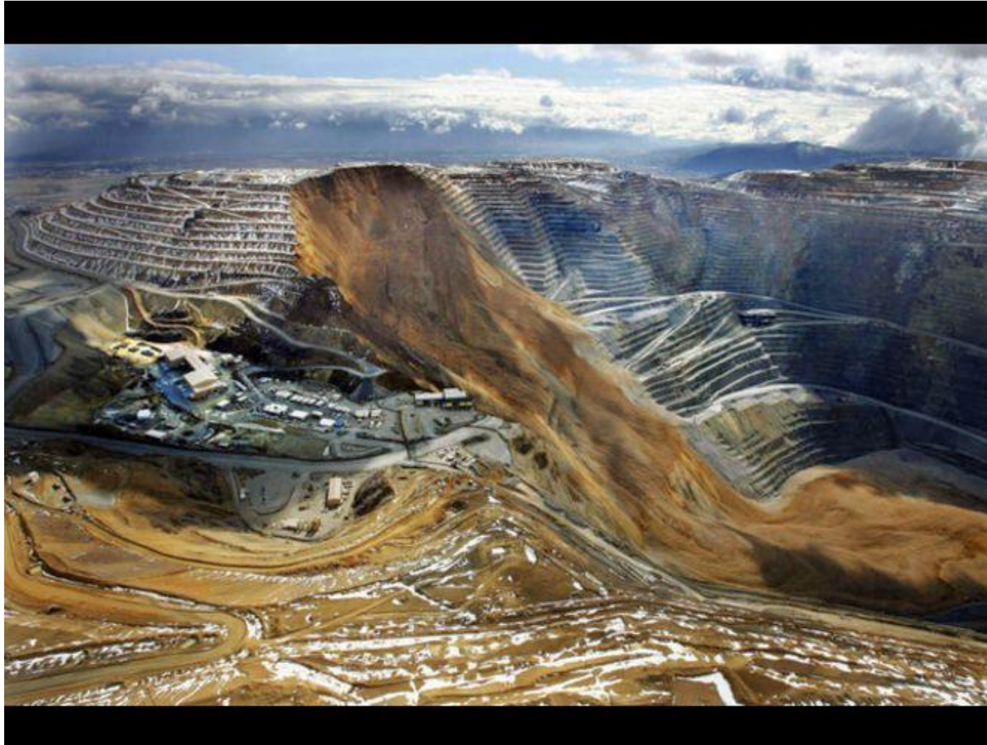
Deslizamiento de tierra en la mina de cobre de Bingham Canyon, USA, 11/4/2013 (Ravell Call / The Deseret News via AP)
