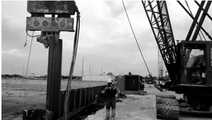
Se instalan en general mediante vibrado y a veces se introducen en el terreno por medio de golpes.
