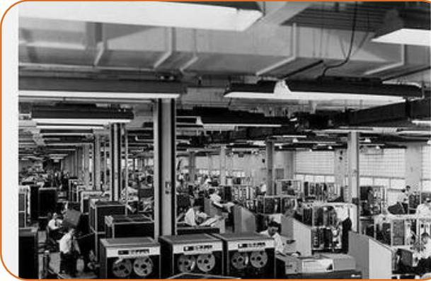
El **IBM 1401** (1960 a 1964) llegó a monopolizar casi un tercio del mercado mundial. Comprendía perforado y lectura de tarjetas a alta velocidad, cinta magnética para entrada y salida, impresión de alta velocidad, programa almacenado, y capacidad aritmética y lógica. Se destacó como un sistema de segunda generación (transistores).
