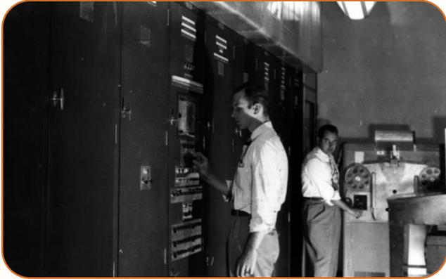
La **EDVAC** (*Electronic Discrete Variable Automatic Computer*) fue diseñada por John Mauchly y John P. Eckert en la Univ. de Pennsylvania (~1945). Tanto los programas como los datos de trabajo estaban almacenados en un solo espacio de almacenamiento unificado. Este diseño básico, que sería conocido como la **arquitectura de von Neumann**, serviría como la base para el desarrollo de las primeras computadoras digitales de propósito general, llamadas de primera generación (válvulas de vacío).
