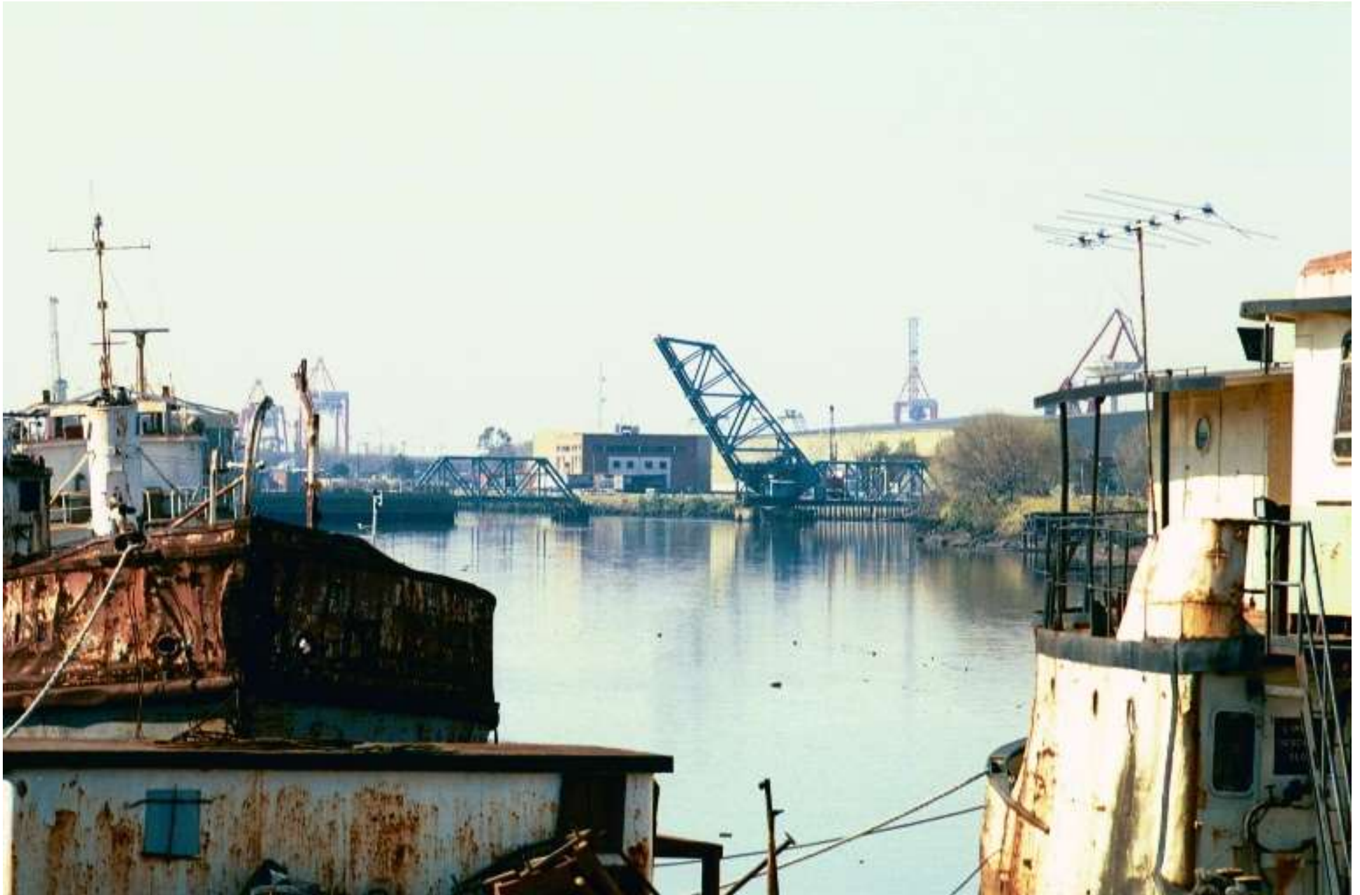
Puente levadizo basculante BARRACA PEÑA - 1913 Riachuelo – Buenos Aires
