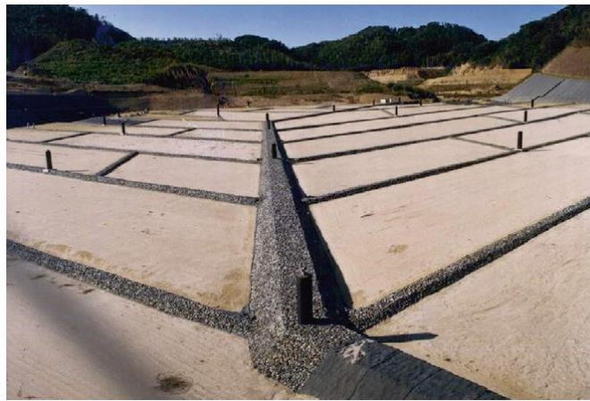
Fig. 2.12: Barrera inferior finalizada con sistema de drenes (Townsed, 2015).
