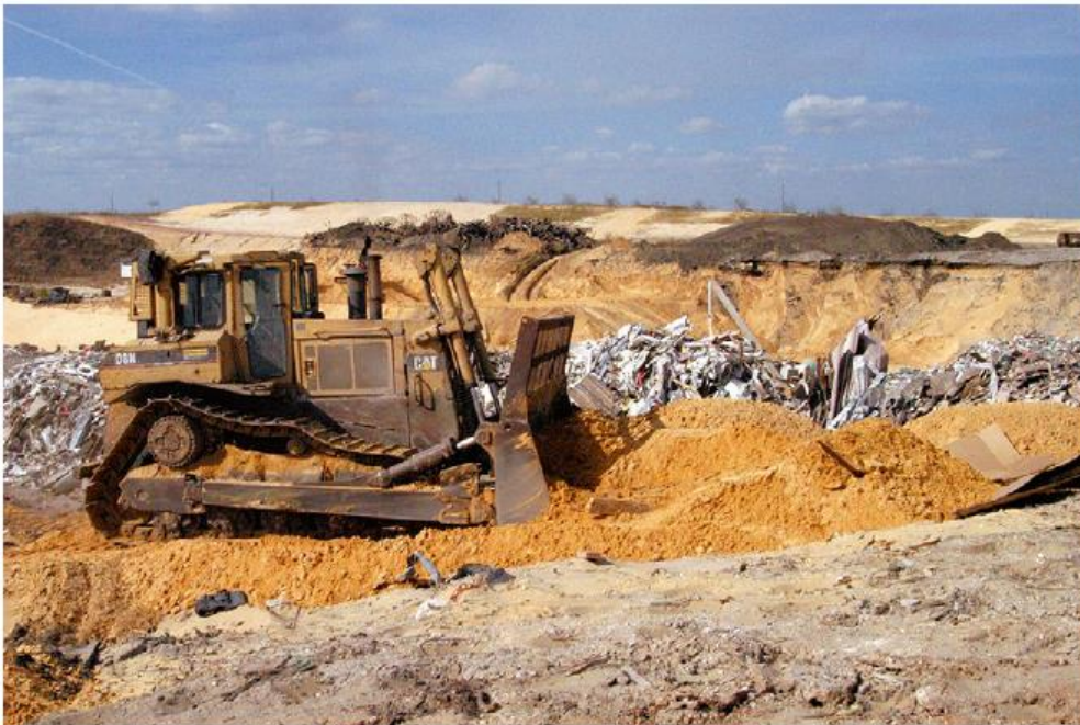
Fig. 2.4: Disposición de suelo de cobertura sobre residuos (Townsed, 2015)
