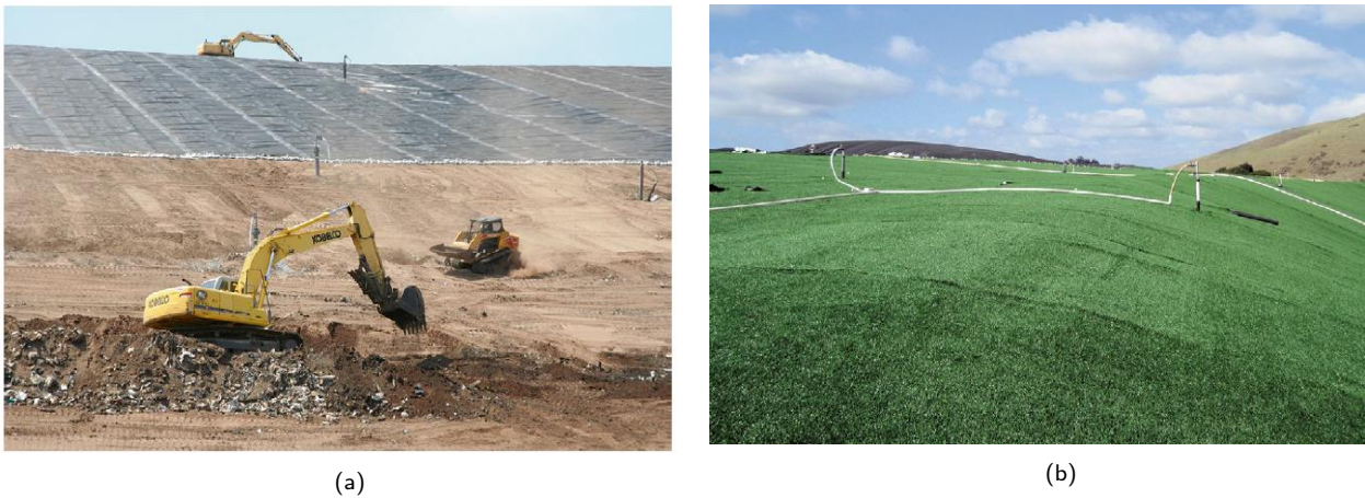
Fig. 2.13: (a) Barrera hidráulica superior en construcción y (b) cierre finalizado con cobertura vegetal y sistema recolector de gases.
