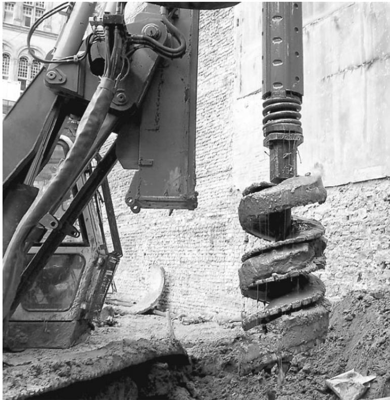
Fig. 2.12: Aplicación de polímeros en excavaciones de pilotes.
