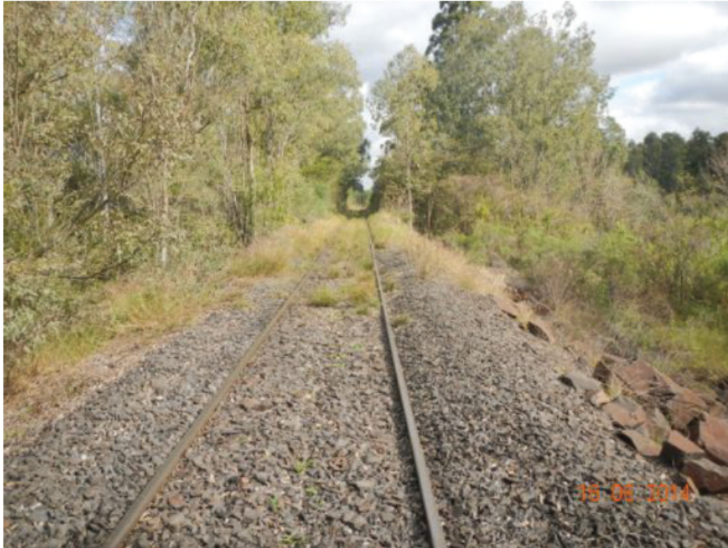
Figura 0.10: PK 70+000. Balasto y Enrocado
