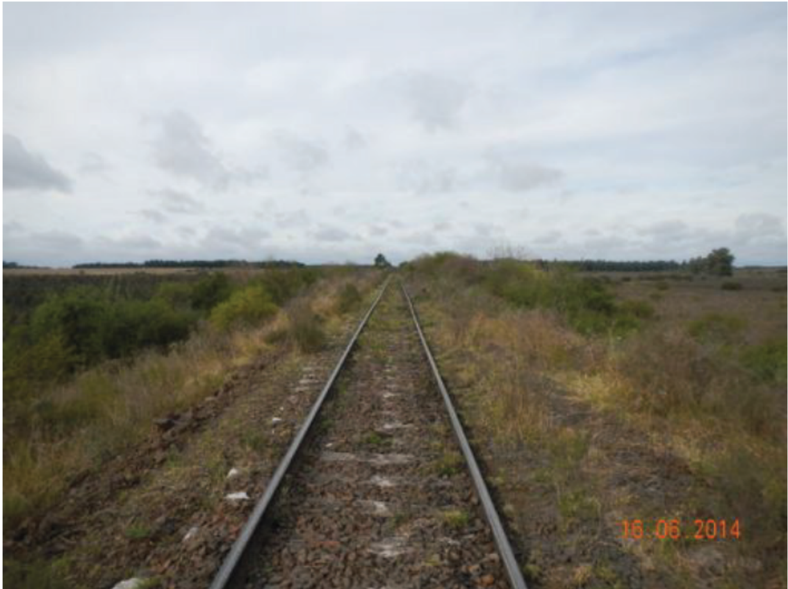
Figura 0.3: PK 36+500. Enrocado y suplemento de balasto.
