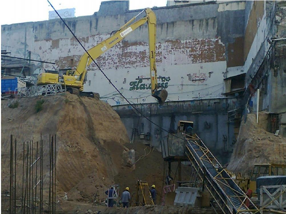
Figura 2.11: Batache de 7m de altura en una excavación urbana de la Ciudad de Buenos Aires.
