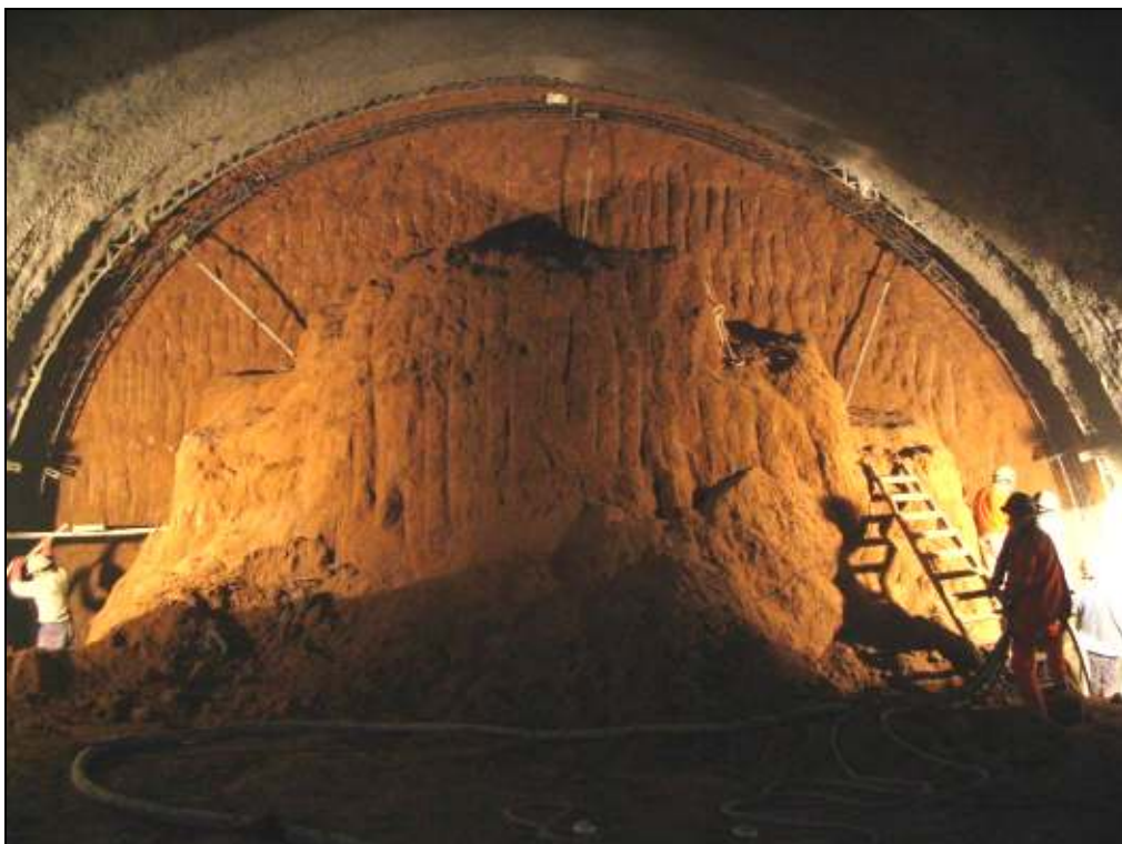
Fig. 3. Túnel Línea B, frente completo, 2005.
