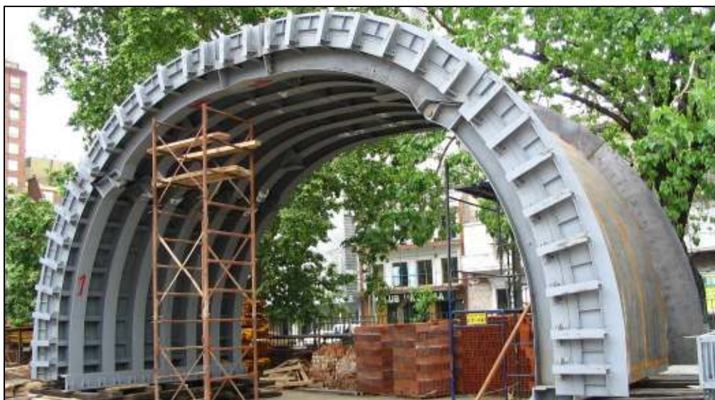
Fig. 9. Molde para método de frente completo. Línea B, 2005.
