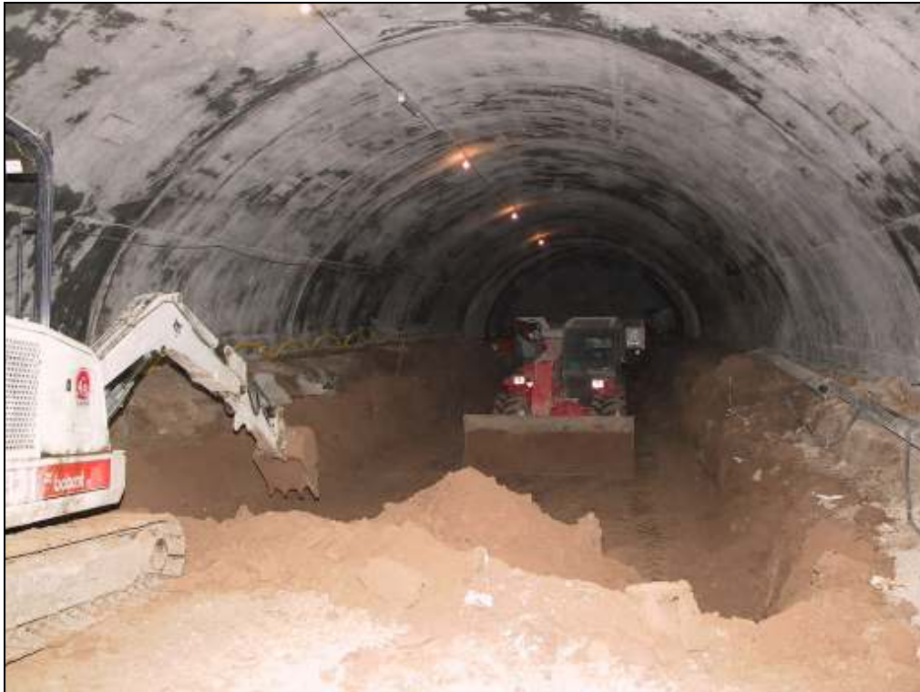
Fig. 2. Túnel Línea H, método belga, 2002.
