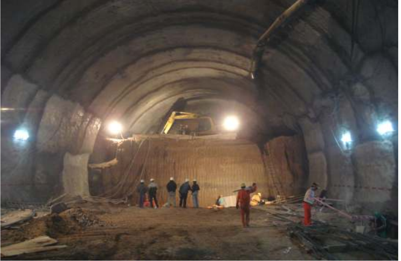
Fig. 10. Otra vista de la caverna principal durante su construcción. Las etapas de excavación pueden verse por las marcas en el sostenimiento de hormigón proyectado .
