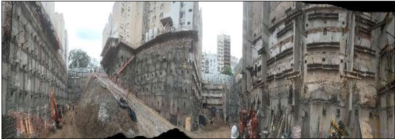
Figura 3 Vista con gran angular que permite tomar gran parte de la obra.
