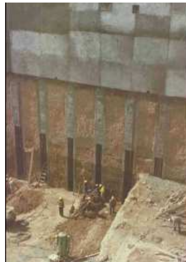
Figura 14: Excavación para el Teatro Argentino de La Plata.
