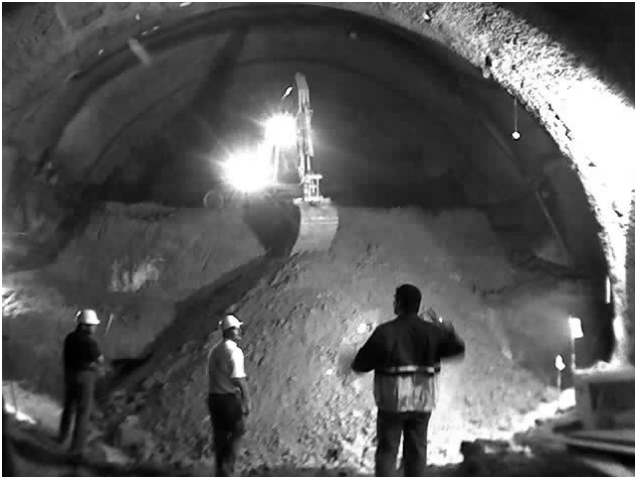
Figura 31: Excavación de la caverna “Estación corrientes”
