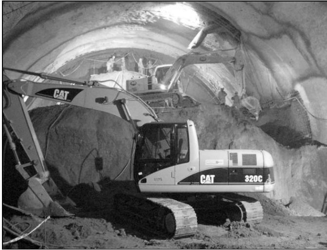
Figura 13: Excavación de la Estación Corrientes, línea H 2008.
