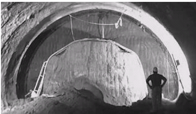
Figura 1. Frente del túnel, línea H.
