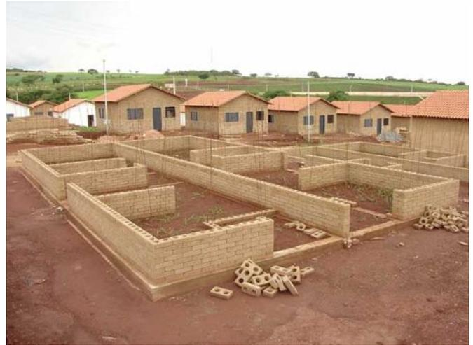
Figura 28: Viviendas construidas con ladrillos de suelo-cemento [25]
