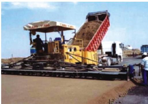
Figura 26: Colocación del suelo-cemento mediante terminadora [11].
