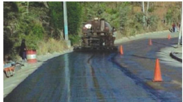
Figura 24: Riego de membrana asfáltica de curado [11].
