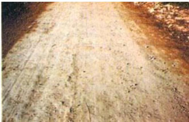
Figura 15: Fotografía de camino rural con carpeta de rodamiento de suelo-cemento [14].
