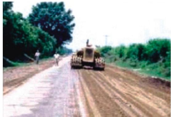
Figura 23: Compactación mediante rodillo “pata de cabra” [11].
