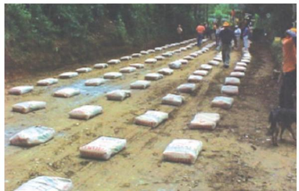
Figura 18: Distribución manual del cemento [11].
