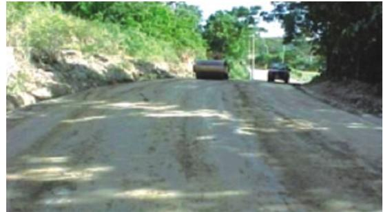
Figura 22: Compactación mediante rodillo liso [11].
