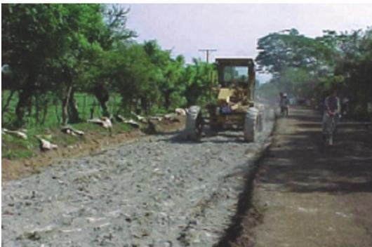
Figura 21: Mezclado del suelo, cemento y agua mediante motoniveladora [11].
