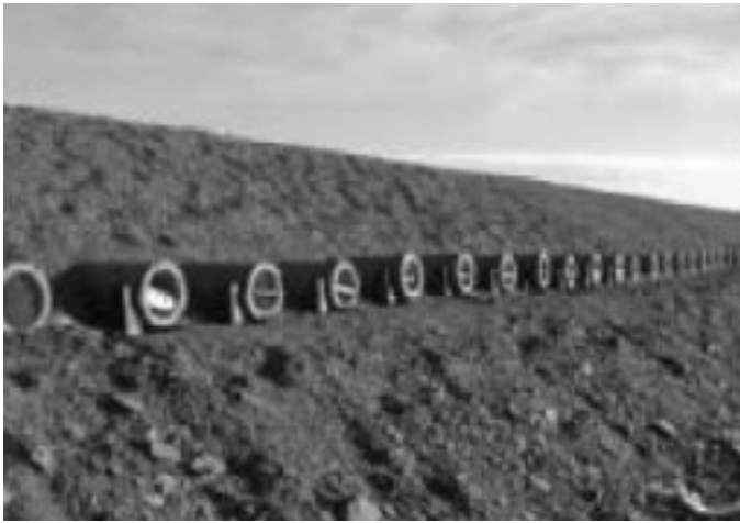
Figura 32: Aplicación de terraplenes ventilados en Alaska (Ferrell 2010).
