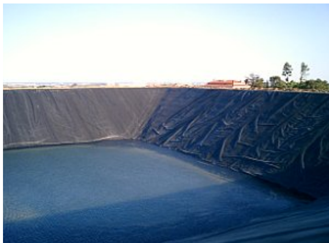
Figura 44: Aplicación de geomembranas para la construcción de lagunas artificiales
