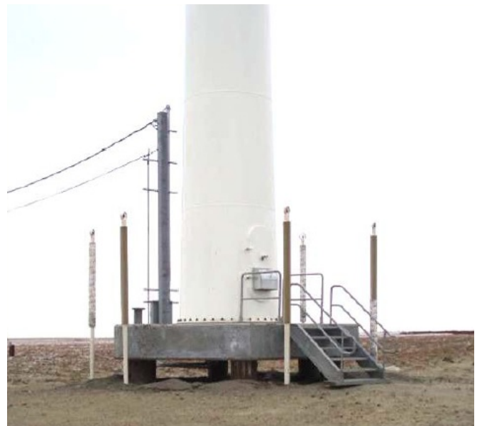
Figura 37: Fundaciones de un parque eólico con termosifones (Dilley y Hulse 2006).
