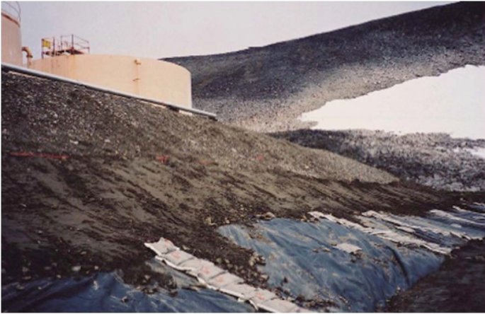
Figura 67: Ejemplo de aplicación de membranas en climas extremos (Bathurst, Rowe, Zeeb y Reimer 2005).
