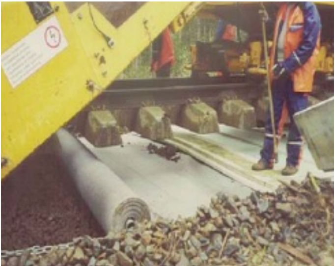
Figura 26: Colocación de aislación de poliestireno (Ferrell 2010).
