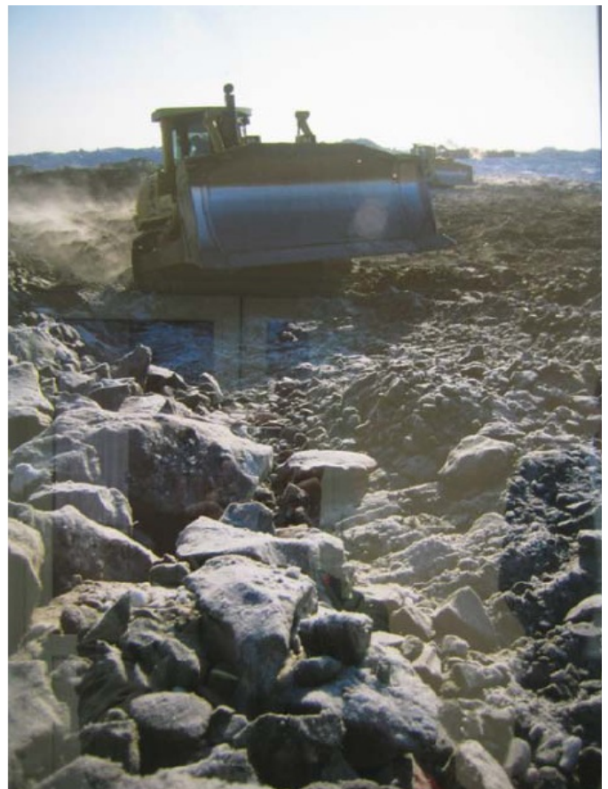
Figura 31: Construcción de un terraplén con enrocado abierto mal graduado (Ferrell 2010).
