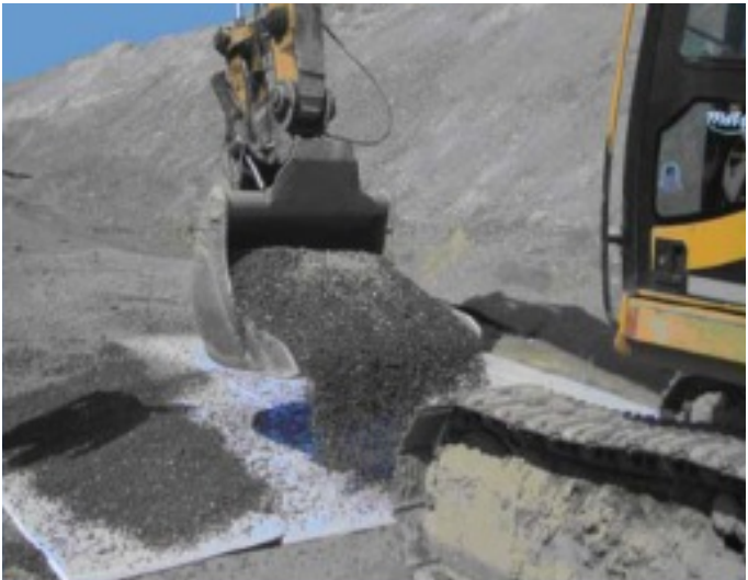
Figura 27: Colocación de aislación de poliestireno (Ferrell 2010).
