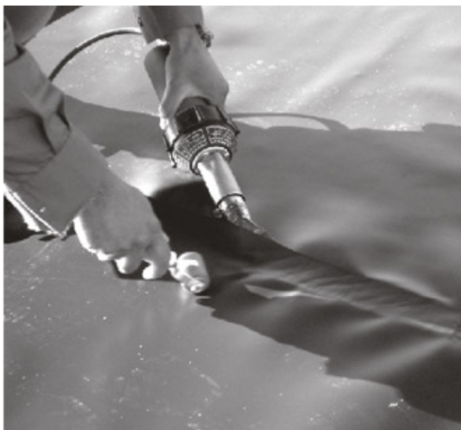
Figura 55: Soldadura de dos paños de geomembrana.
