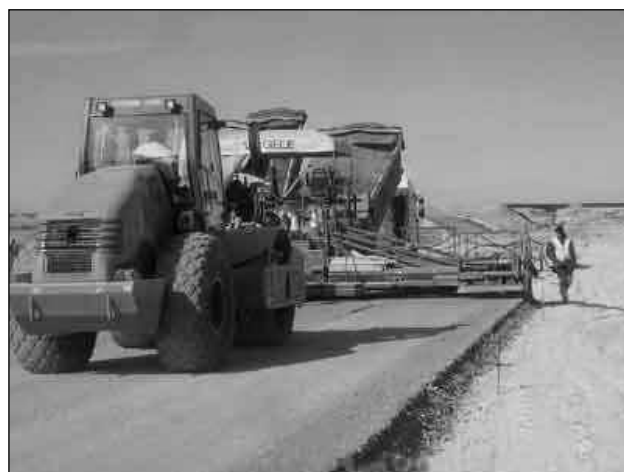
Figura 2-1. Construcción de una sub-base para un pavimento rígido.
