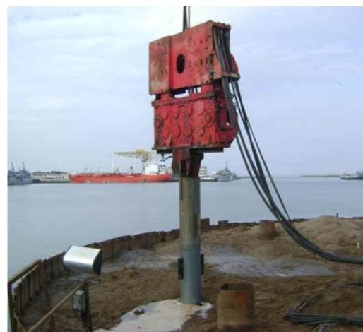
Figura 1.5: Densificación con tubo aleteado.
