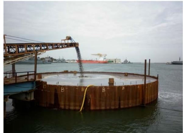
Figura 1.4: Llenado de las celdas mediante refulado.
