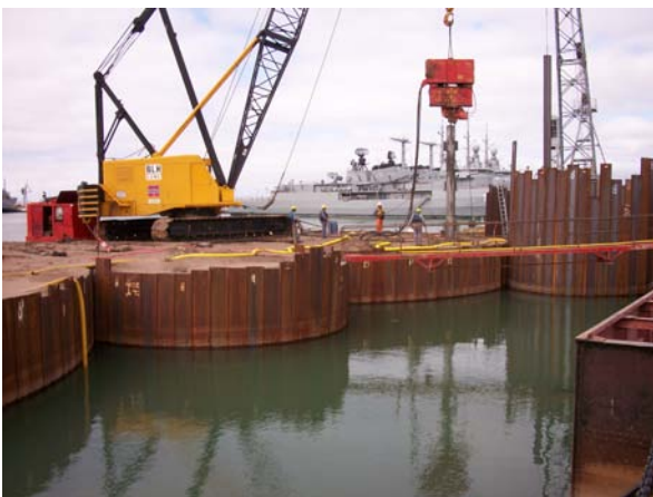
Figura 2.2: Dique Carena. Vista general.
