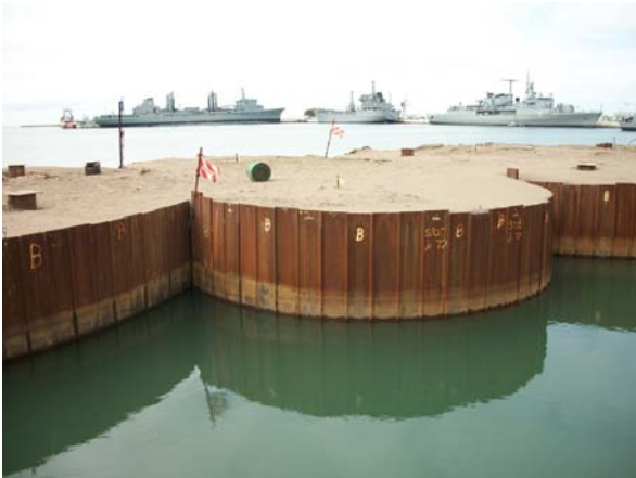
Figura 2.1: Dique Carena. Vista general.
