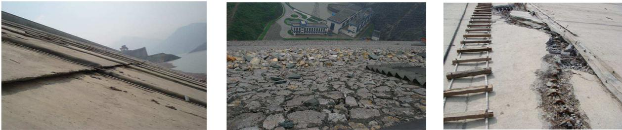
Figura 2.3: Daños en juntas horizontales (izq.), talud aguas abajo (centro) y juntas verticales y pantalla (der.) en la Presa Zipungpu
