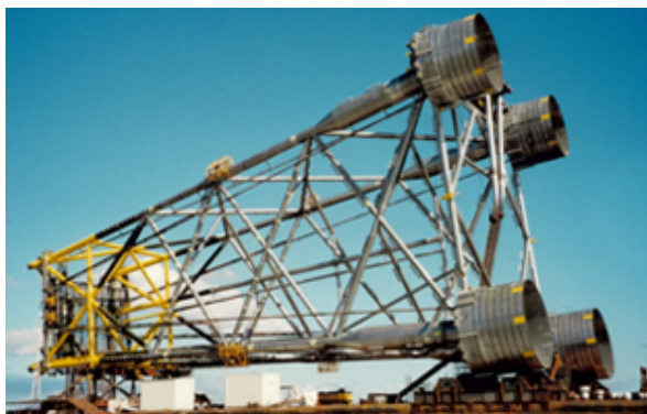
(a) Infraestructura con suction caisson lista para ser trasladada.
