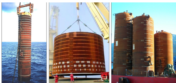
(b) Distintos tipos de suction caisson
