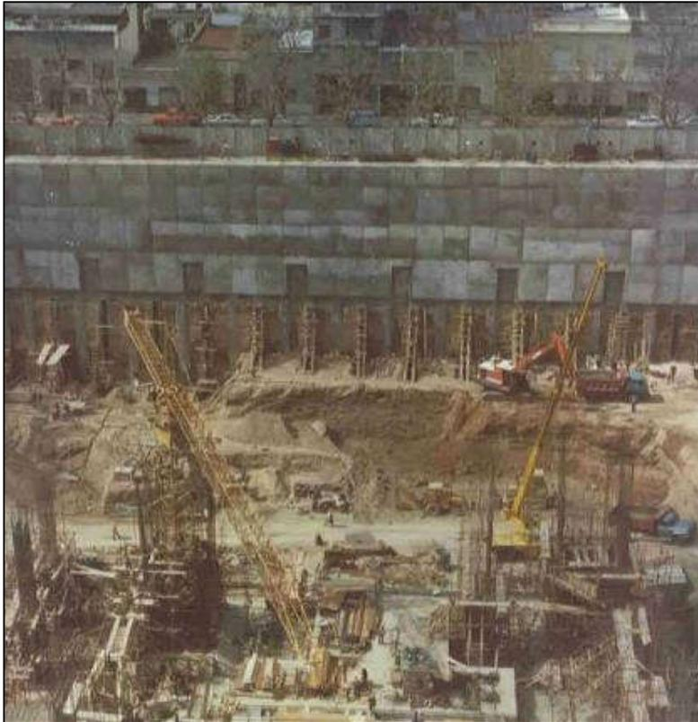
**Figura 1-1. Excavación profunda en la Ciudad de La Plata, Provincia de Buenos Aires (Núñez, 1980).**
