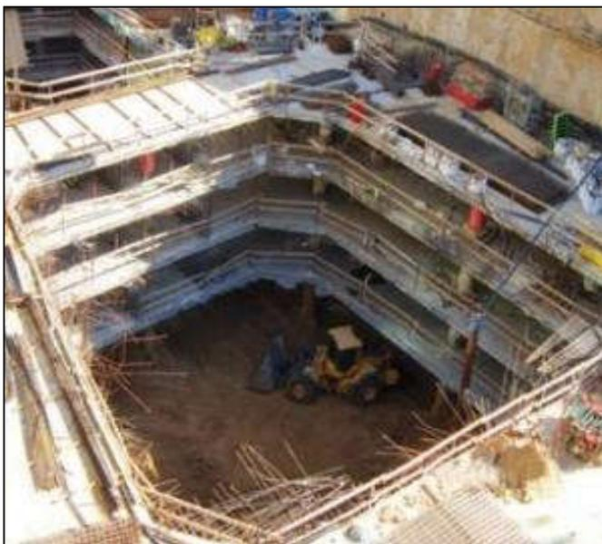
Figura 4-7. Vista de una excavación ejecutada con sistema *top-down* (El-Har).
