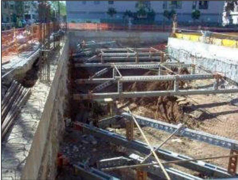
**Figura 4-8. Ejemplo de una excavación sostenida con puntales metálicos (RMD Kwikform).**
