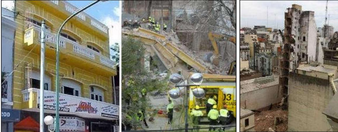
**Figura 1-3. Ejemplos de derrumbes durante excavaciones. izq) Mendoza 5030 (Agosto 2010) y der) B. Mitre 1232 (Noviembre 2011), ambos en la Ciudad de Buenos Aires.**
