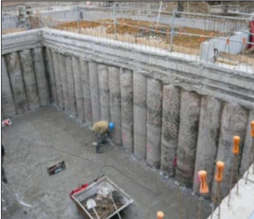
**Figura 4-5. Vista de una pantalla de pilotes (Durmeyer).**
