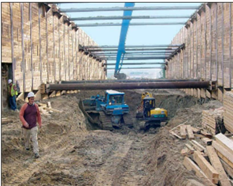
**Figura 4-6. Excavación sostenida con muro berlinés y puntales (Yepes Piqueras 2014).**
