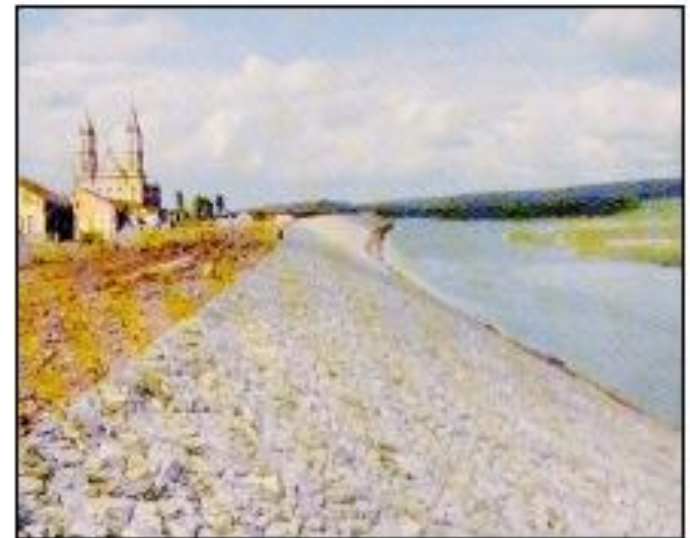
Protección con Colchonetas
