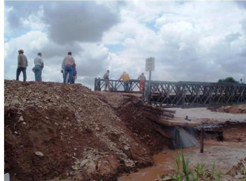
Imágenes del puente provisorio colocado aguas abajo del principal, para el cruce temporal
