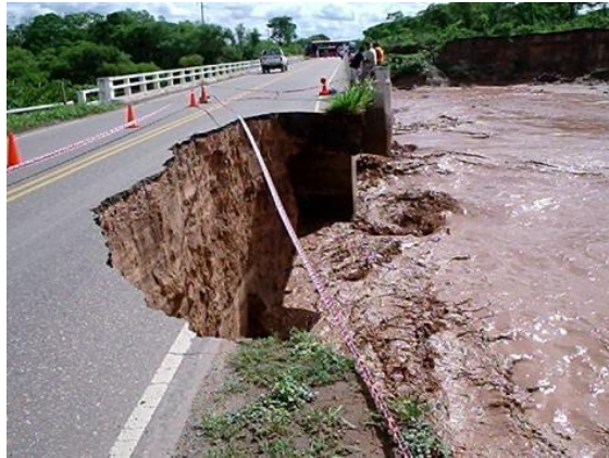
Inicio del proceso erosivo de socavación sobre la margen izquierda, por pérdida del terraplén de aproximación.
