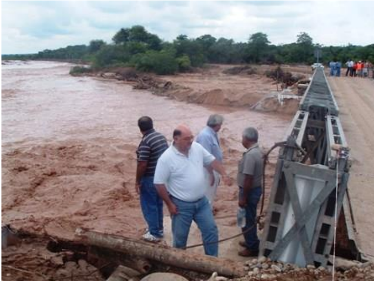
Imágenes del puente provisorio colocado aguas abajo del principal, para el cruce temporal
