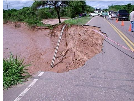
Inicio del proceso erosivo de socavación sobre la margen izquierda, por pérdida del terraplén de aproximación.
