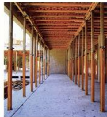
Con una distancia de 2,70 m entre las doble vigas y una distancia de 120 cm entre los puntales, la GT 24 permite encofrar losas con un espesor de hasta 260 mm.
