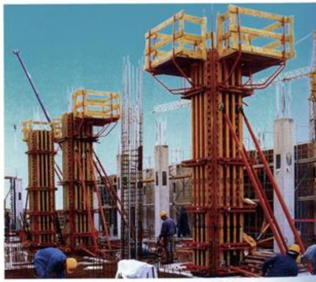
Pilares con secciones de hasta 80 x 120 cm con SGRZ 181 y SVRZ 120.
