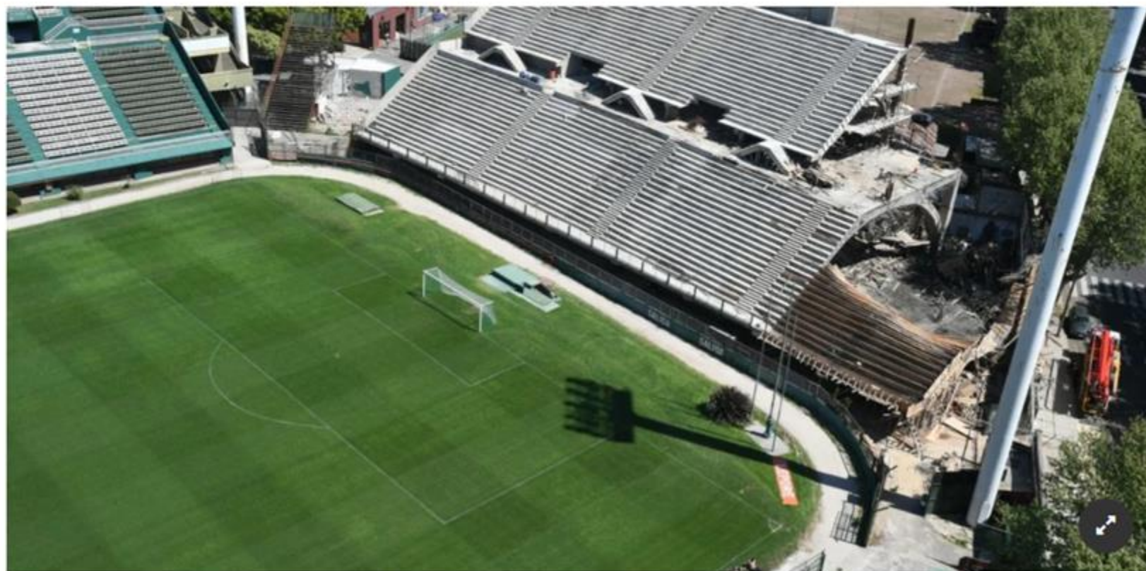
Se derrumbó una tribuna en construcción de la cancha del club Ferrocarril Oeste Ferro Foto Télam
