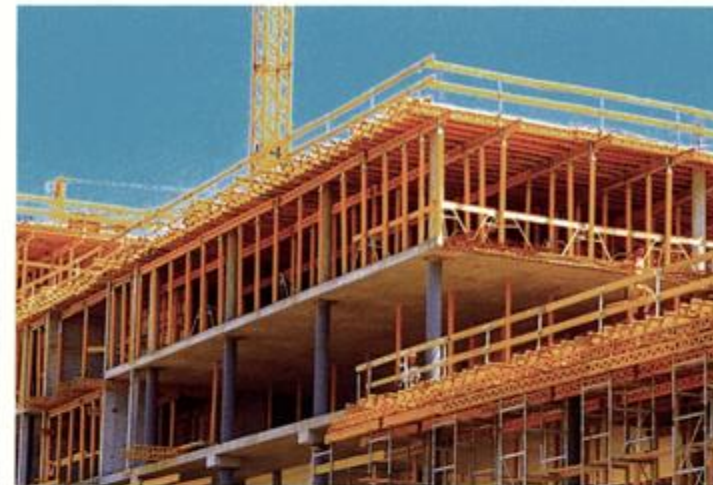
MULTIFLEX GT 24 sobre puntales MULTIPROP.
