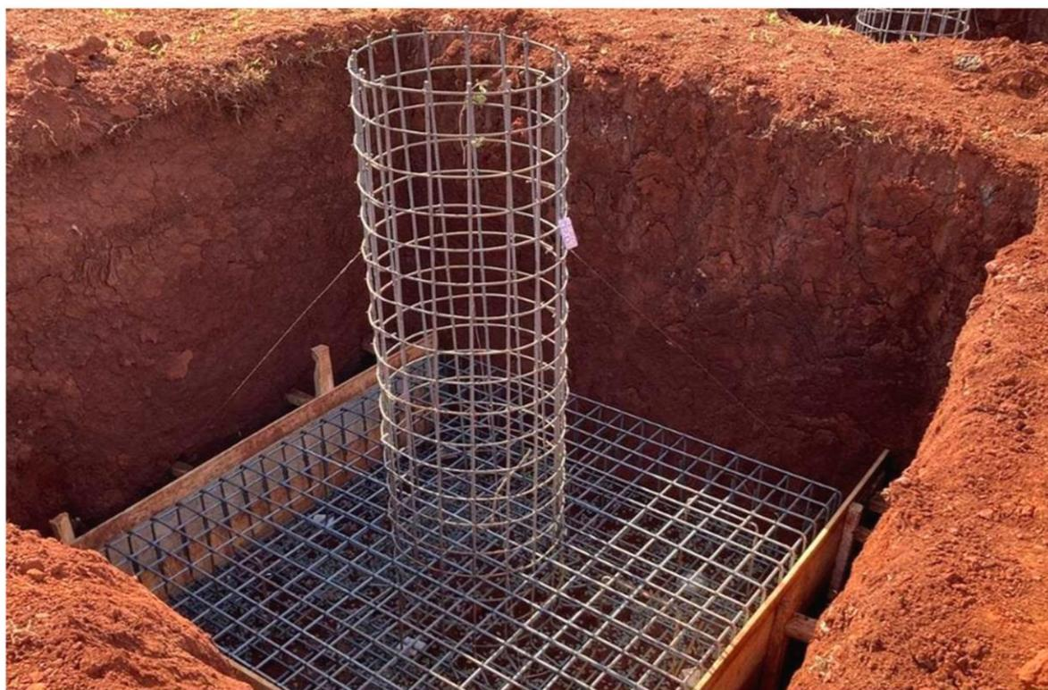
Excavación para cimiento. Se realiza con retroexcavadoras que dan la forma que el cimiento tiene. Se observa la armadura de la base y sus maderas de encofrado.
