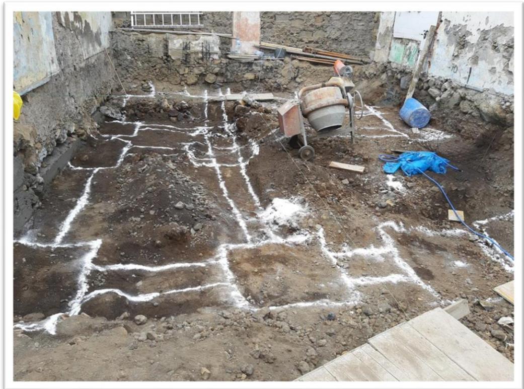
Replanteo de bases. Se observan las marcaciones realizadas sobre el terreno donde se ejecutarán los trabajos. Las mismas son las bases del edificio, con sus respectivas vigas de fundación. El trabajo se realizó estableciendo ejes de referencia para poder replantear dichas bases y comenzar las excavaciones de las mismas con maquinaria.
