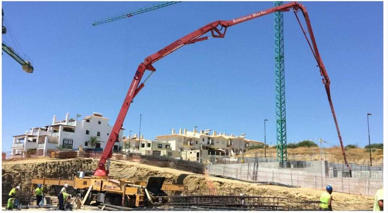
Se observa un hormigonado por bombeo. Se emplea esta técnica cuando son obras de gran envergadura, como puentes, túneles, autopistas, etc. El brazo o manguera permite verter el hormigón con precisión. Se emplea también en entornos complicados, donde es difícil acceder con otro tipo de maquinaria o en construcciones con altura como, por ejemplo, el hormigonado del Burj Khalifa.
