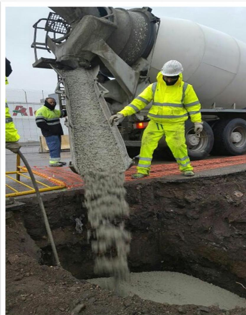
Descarga de hormigón. Se observa el camión hormigonero detrás. Estos camiones tienen un tambor, donde se encuentra el hormigón a colocar, rotando constantemente. Esto es debido al fraguado, evitando que el hormigón se endurezca antes de que llegue a la obra. Mantiene a la mezcla trabajable hasta la colocación.
