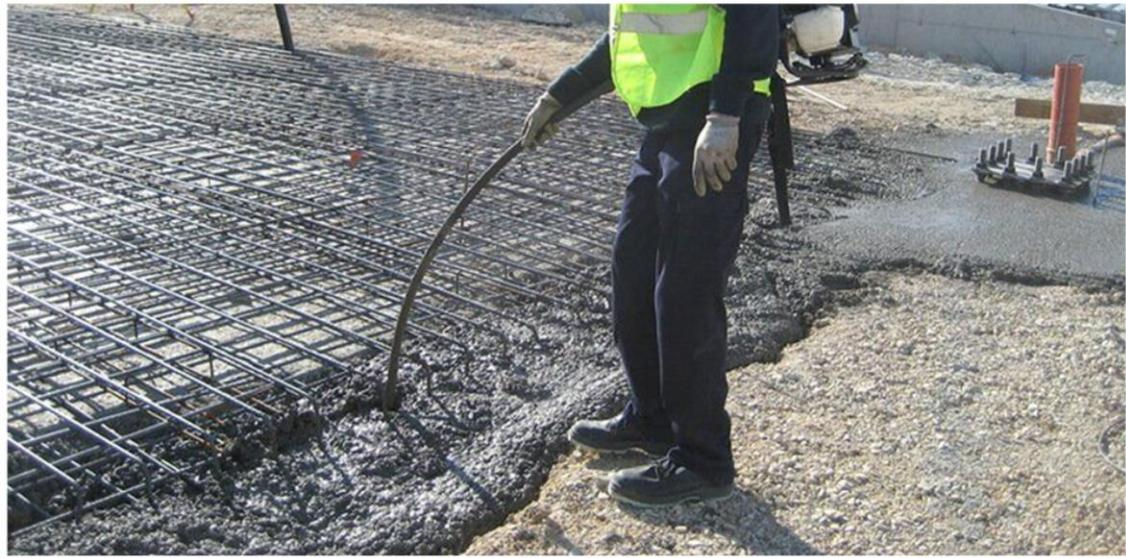
Vibrado de hormigón. En ocasiones donde la consistencia del hormigón no permite una óptima trabajabilidad para ser fácilmente colocado, se emplean vibradores de hormigón con fin de que quede perfectamente asentado en cada parte, sin burbujas de aire dentro, lo cual podría afectar el fraguado del aglomerante.
