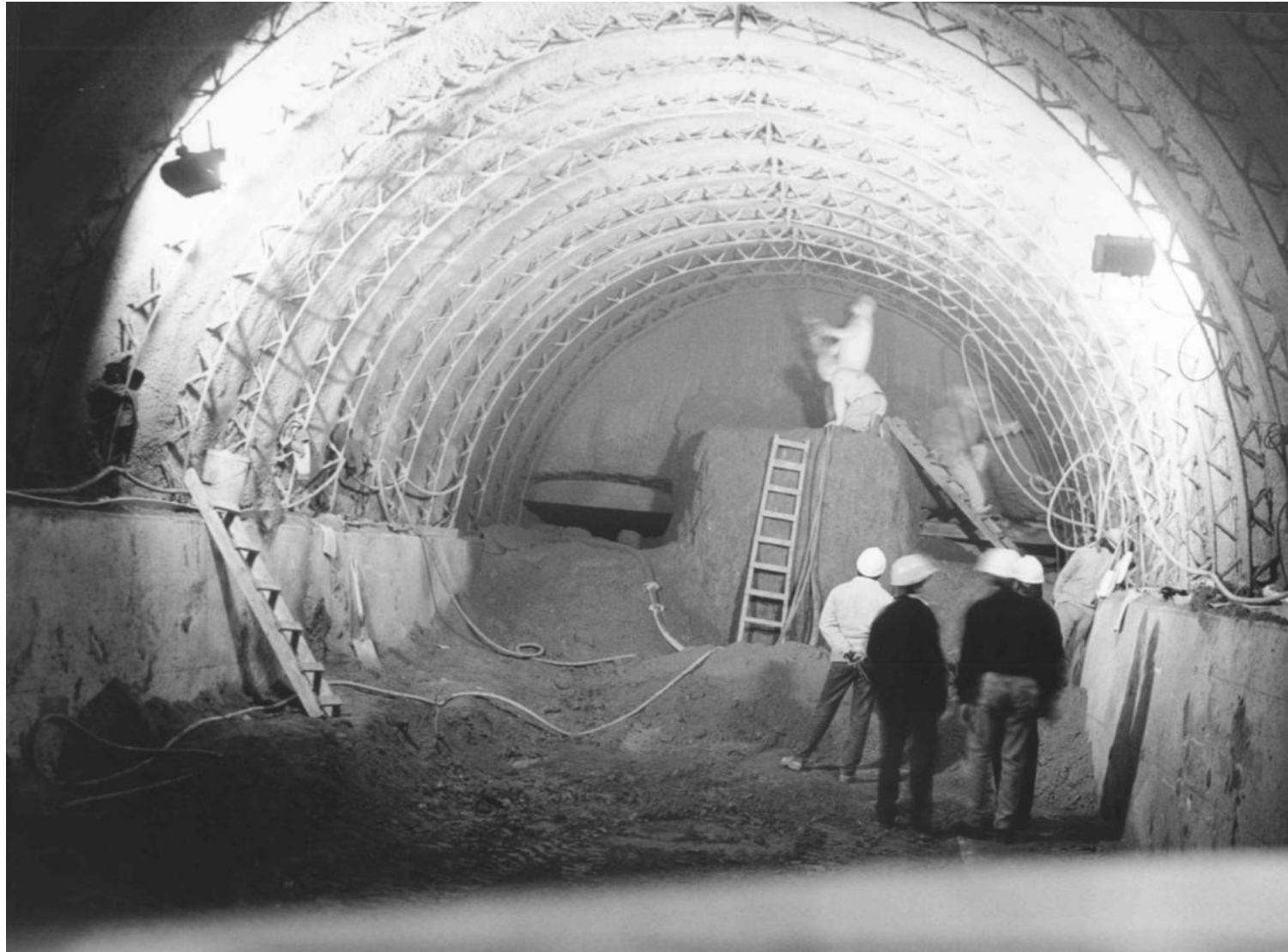
(Sfriso – Primer túnel Subte con NATM – 1998)
