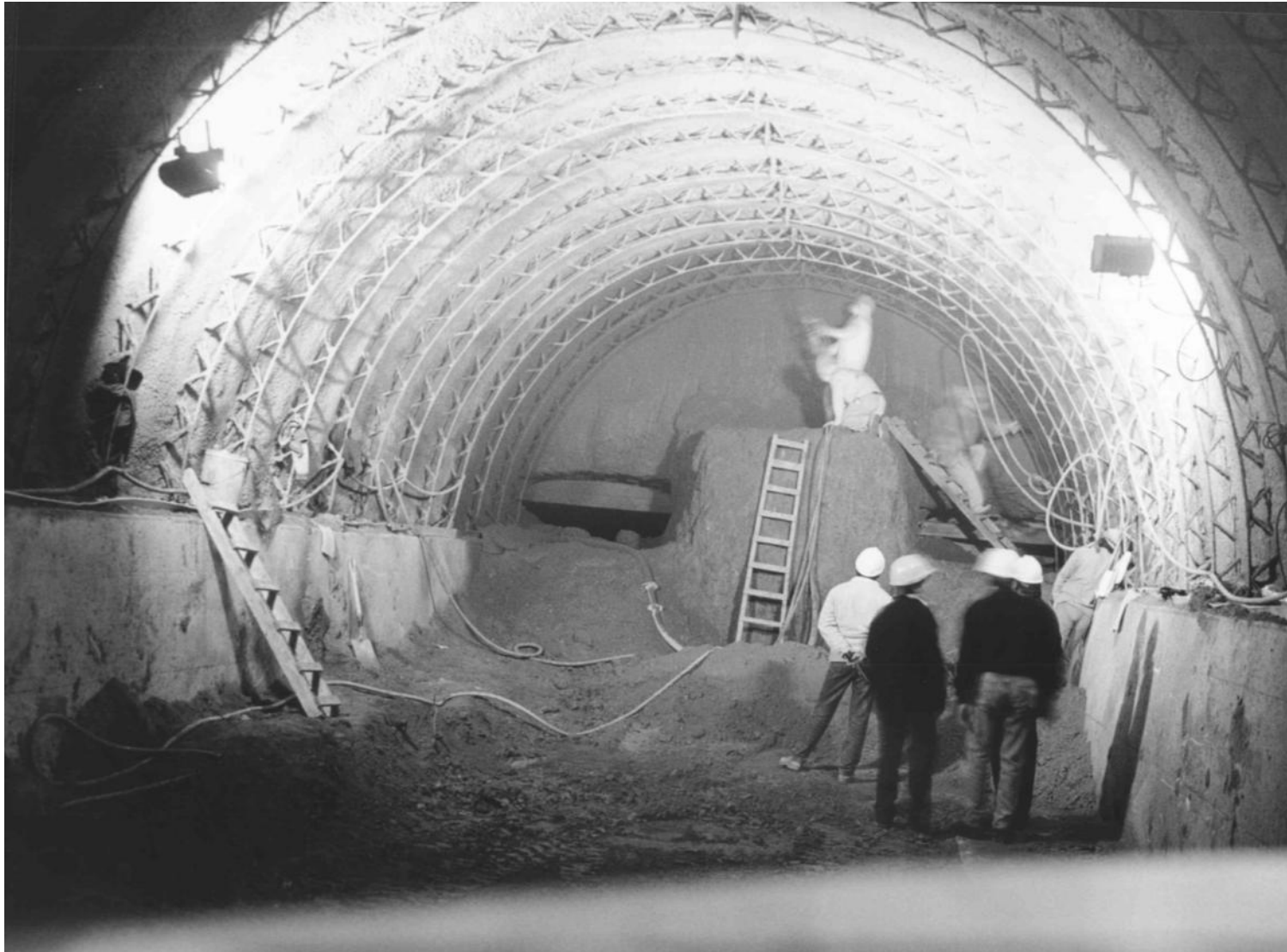
(Sfriso – Primer túnel Subte con NATM – 1998)
