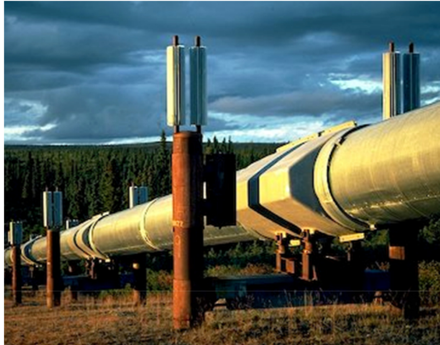
Apoyos de tuberías (Barker J. 2013)
