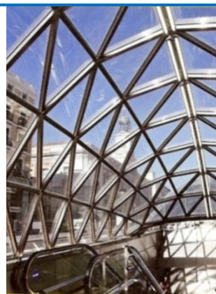
Cerramiento de aluminio en una estación de cercanías.
